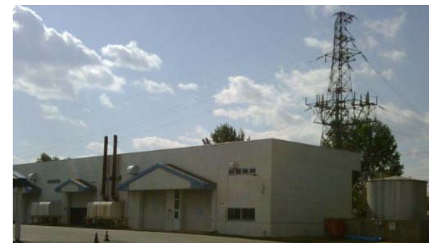
【山形工場 自家発電装置棟】
