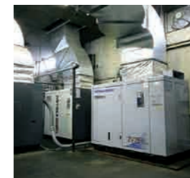
インバータ方式のコンプレッサーを導入(甲府工場)
