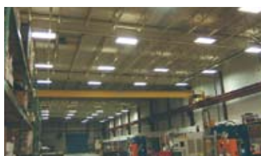
リンクボール工場の照明を白熱灯からエネルギー効率の良い蛍光灯に変更
