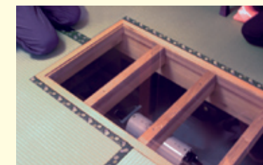
自宅にも免震装置を設置。お客様にご覧いただけるよう、畳の一部をガラス張りに。
