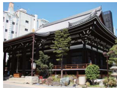
本願寺全景 床下と屋根裏に制震装置、本堂内須弥壇に免震装置を採用
