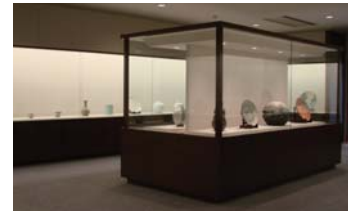
免震装置を施した展示収蔵庫
