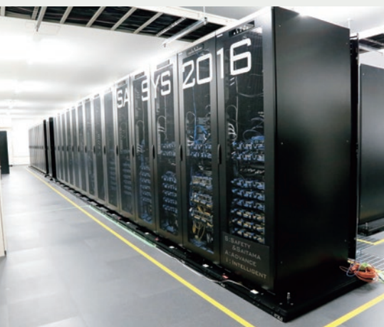
サーバーを守る免震装置
