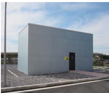
大型水浄化槽装置 (排水は緑地散水にも利用)
