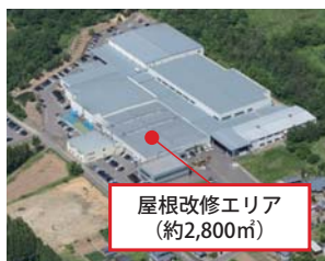
『遮熱』効果のある屋根改修を実施
