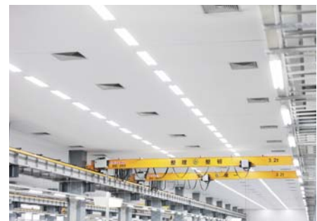
研削工場LED照明 (従来の水銀灯に比較し、約3分の1の電力消費)
