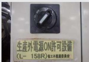
電源を切らなくて良いものを表示札で明確化
