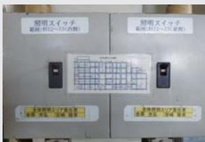
スイッチを設備等の前面に集約させる等「切り易化」
