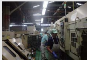
製造ラインの照明にLED人感センサーを設置(自動ON-OFF)
